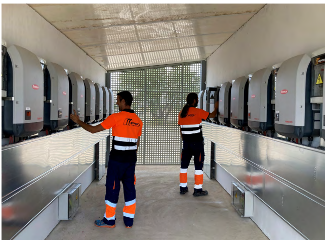
/ Técnicos de Norsol poniendo a punto los 18 inversores Fronius Eco
